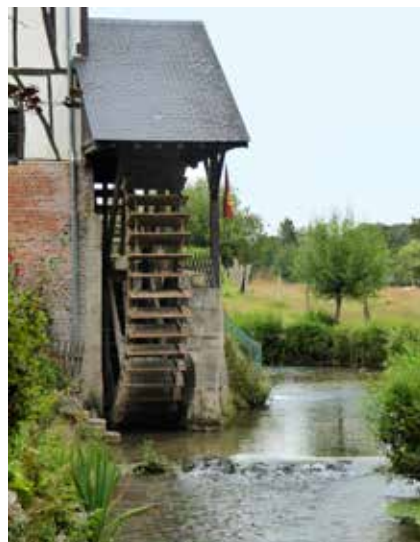
Sur le circuit du Crevon
