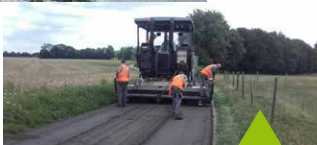
Reprofilage de chaussée en graves émulsion
