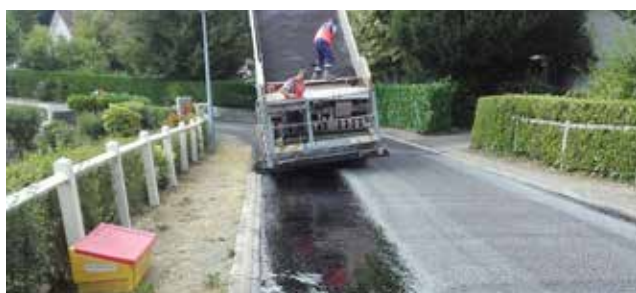
Application d'enduit superficiel gravillonné
